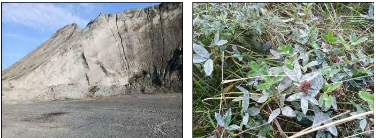
Рисунок 17. Незакрепленный откос отвала фабрики №5, сложенный мелкой фракцией отходов фабрики №5 и листья клевера в нескольких десятках метров от него (слева – вид откоса отвала фабрики № 5 в 200 м северо-восточнее от полигона РМЗ)
